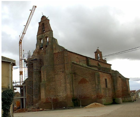
Obra, vista desde la parte norte, donde se observa todo el campanario, con los contrafuertes
