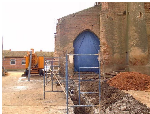
Momento de las obras, con la sacristía derribada, y viéndose la entrada por el contrafuerte al campanario
