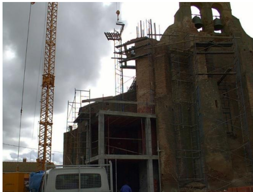
Obra donde ya se va viendo la nueva torre cilíndrica que va por el interior de la sacristía para la subida al campanario, parte del contrafuerte reformado
