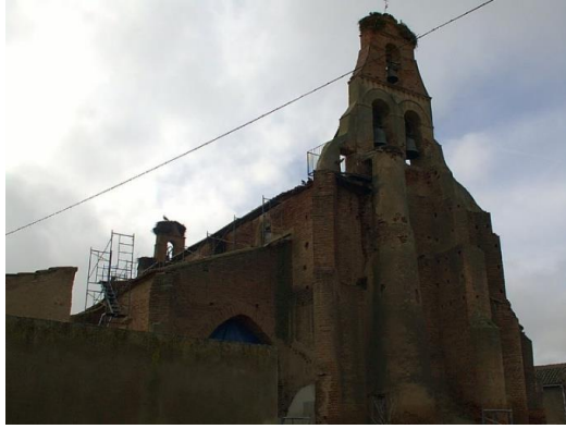
Derribada la sacristía y se deja ver todo el contrafuerte por el que subía al campanario, de forma cilíndrica
